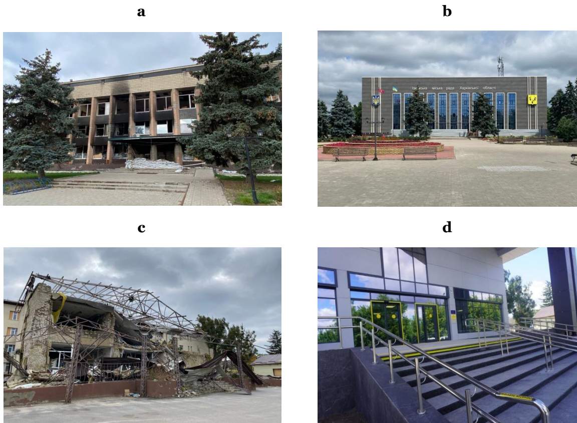
Рисунок 1. Руйнування інфраструктури та відновлення за принципом «краще ніж було» (а: масштабні руйнування будівлі міської ради у м. Ізюм, 2022 р., б: відновлена будівля міської ради в м. Ізюм, 2024 р., с: зруйнована Ізюмська лікарня, 2022 р., d: відновлена Ізюмська лікарня, 2024 р. Фото авторів)
