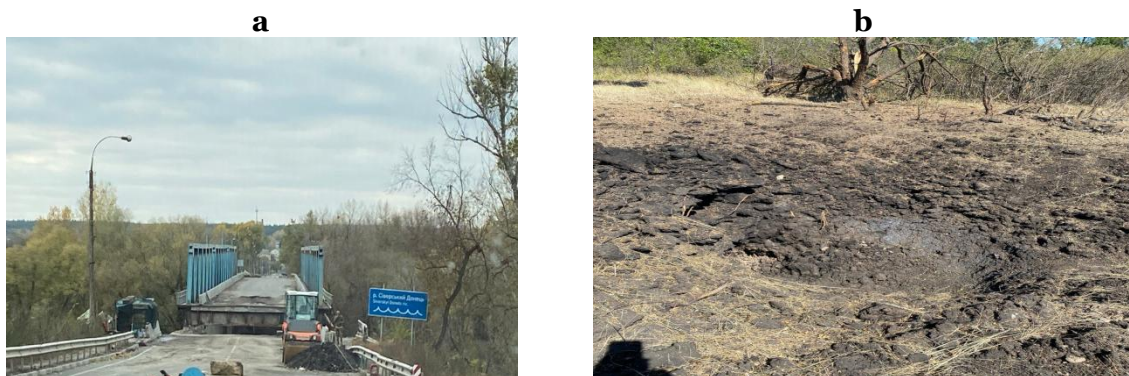
Рисунок 3. Руйнування інфраструктури мостів та забруднення ґрунтів Ізюмської міської територіальної громади (а: руйнування мосту через р. Сіверський Донець, 2022р., б: ґрунти, забруднені вибуховими речовинами. Фото авторів)
